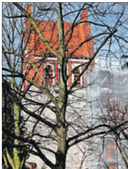
Die Königin-Luise-Kirche während ihrer umfangreichen Sanierung. Foto: W. Nieschalk
